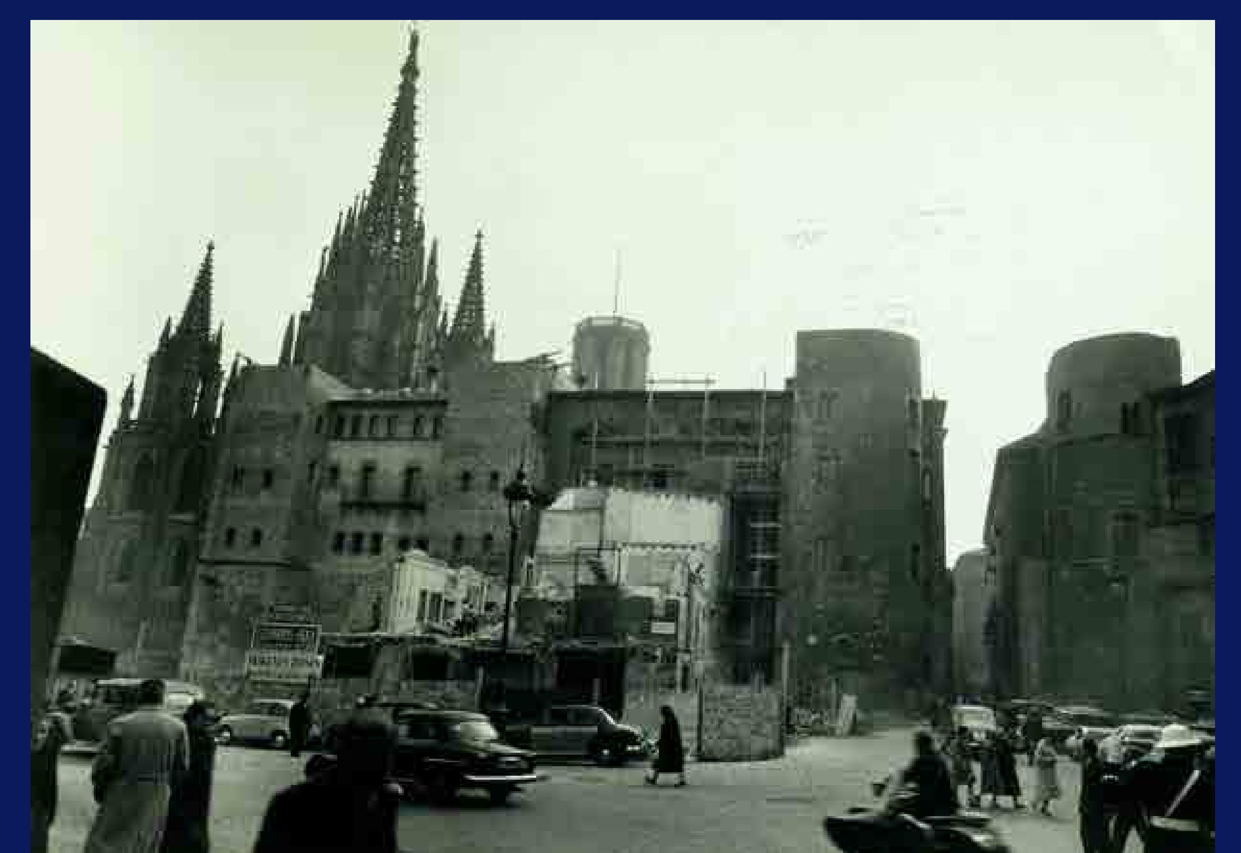
Enderroc d'edificis de la plaça Nova, 1957. AFB.
