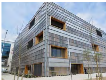
Imatge: edifici ICTA-ICP (inaugurat l'octubre de 2014).
